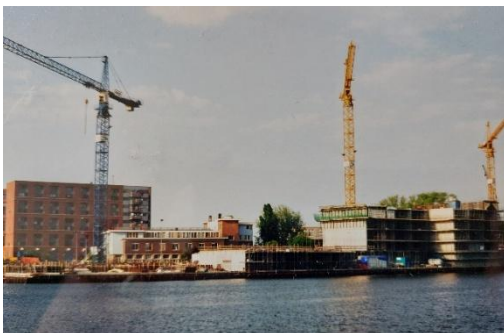
2000: Hoogkade in aanbouw
