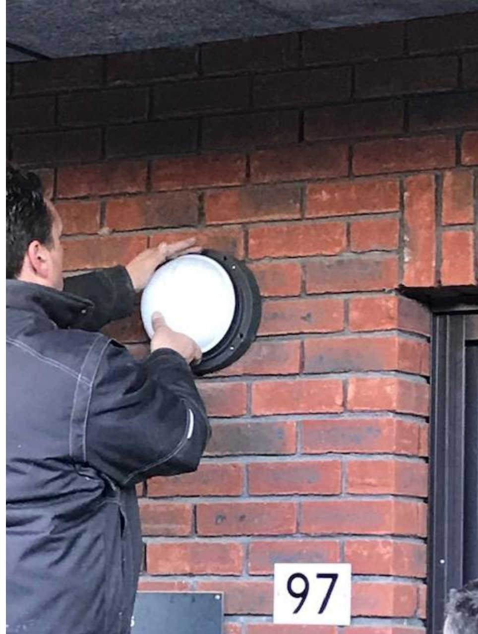
14 mei - aanleg extra lampen buitenverlichting
